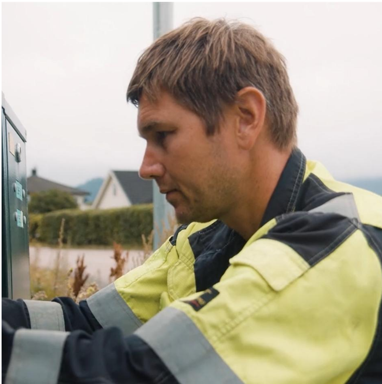
Arnstein Kjos driftsleder for Øvre Eiker Fibernett kontrollerer fiberkoblinger.
